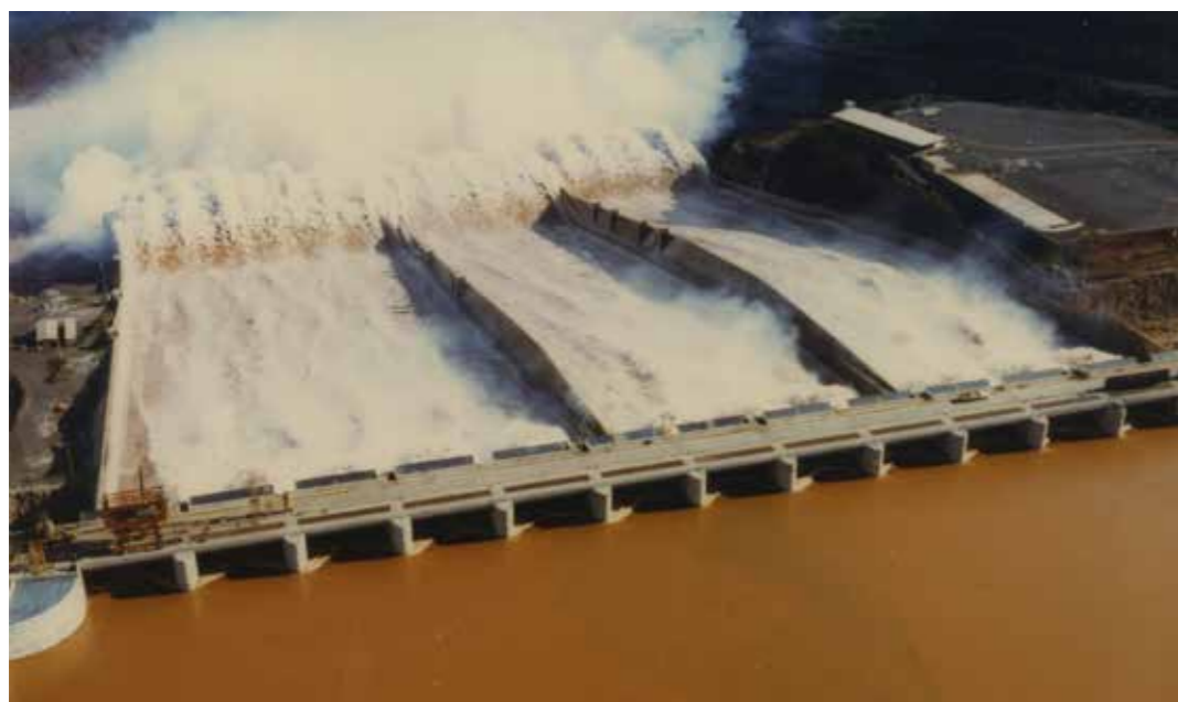
Usina Hidrelétrica Itaipu (Montagem Eletromecânica) Terminal Marítimo Macaé II
